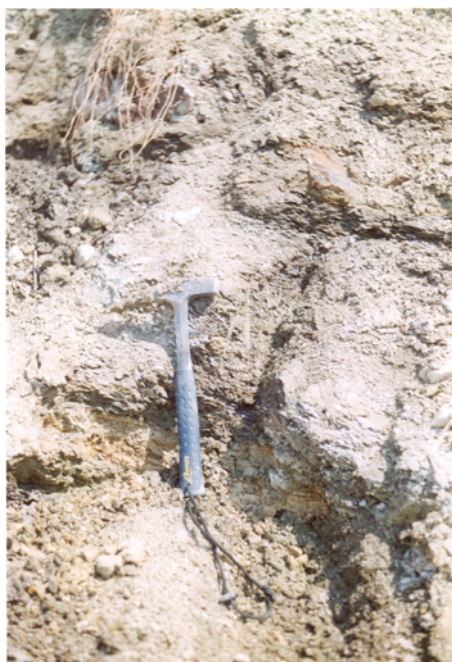
Fig. 3a – Affioramento ubicato in sinistra idrografica del T. Laio all'altezza della progressiva 8+150 (235 m s.l.m.): COMPLESSO CAOTICO (7) – Particolare dell'alternanza di marne, argilla e marne argillose, di colore grigiastro, intensamente tettonizzata.
