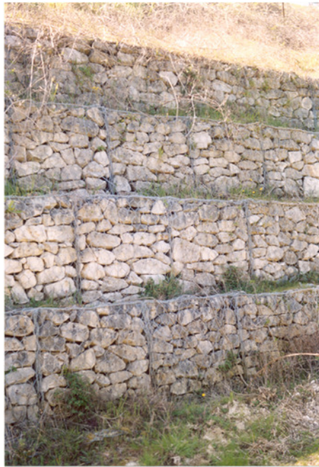
Fig. 21 – Particolare ubicato a W di S. Antonio in località Laroma (230 m s.l.m.) – Muro di ritenuta a secco realizzato a protezione dell'assetto stradale; è costituito da pietre organizzate a gradoni e sostenute da rete metallica.
