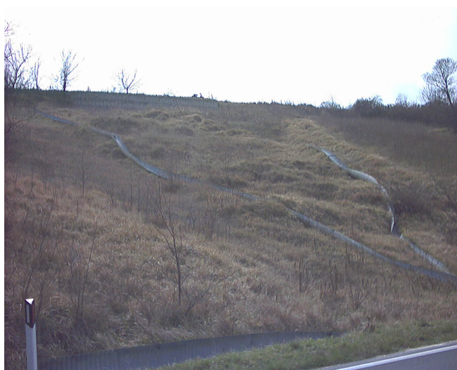
Fig 16 - Fenomeno di dissesto interessato da interventi di regimentazione delle acque superficiali situato a monte della statale in corrispondenza del sondaggio S9
